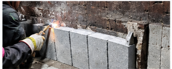
06 비철금속 용해로 내화물 설치
