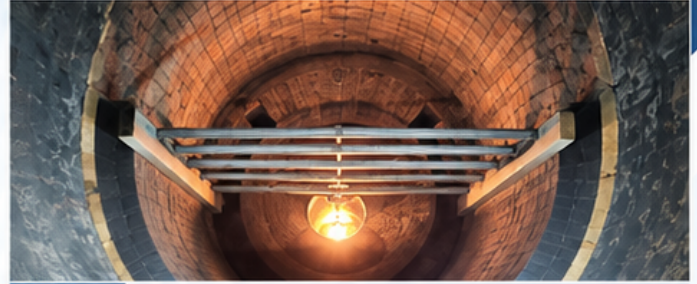
02 ROTARY KILN 내화물 설치
